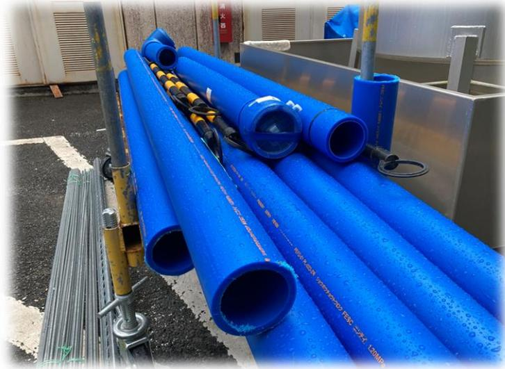
やまゆり荘の地下に張り巡らされているスプリンクラーの配管を確認したところ、老朽化により一部に亀裂・漏水がありましたので、現在、配管の修繕工事を行っています。
